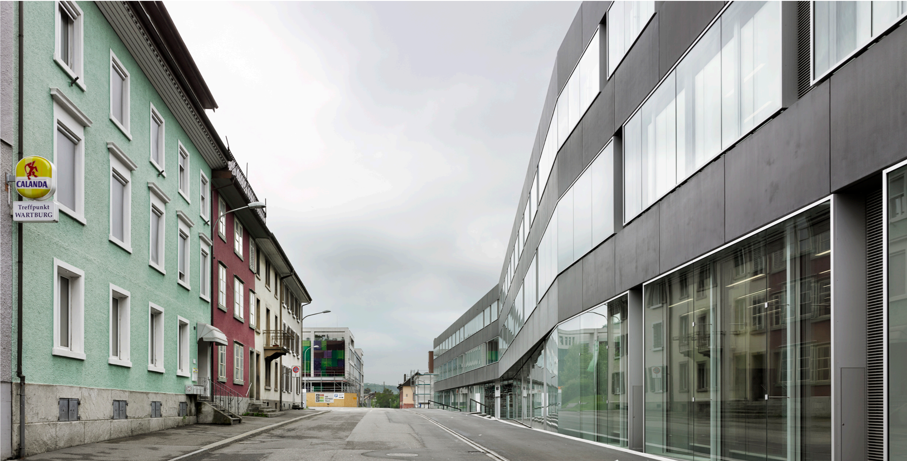
FHNW Olten, Von Roll Strasse, Ostfassade, Seiteneingang
