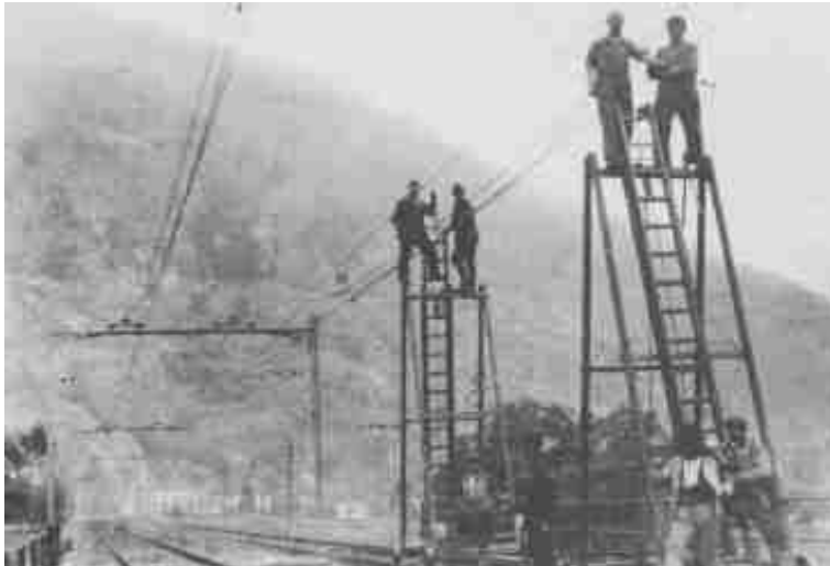
Électrification de la ligne ferroviaire du Saint-Gothard en 1916
