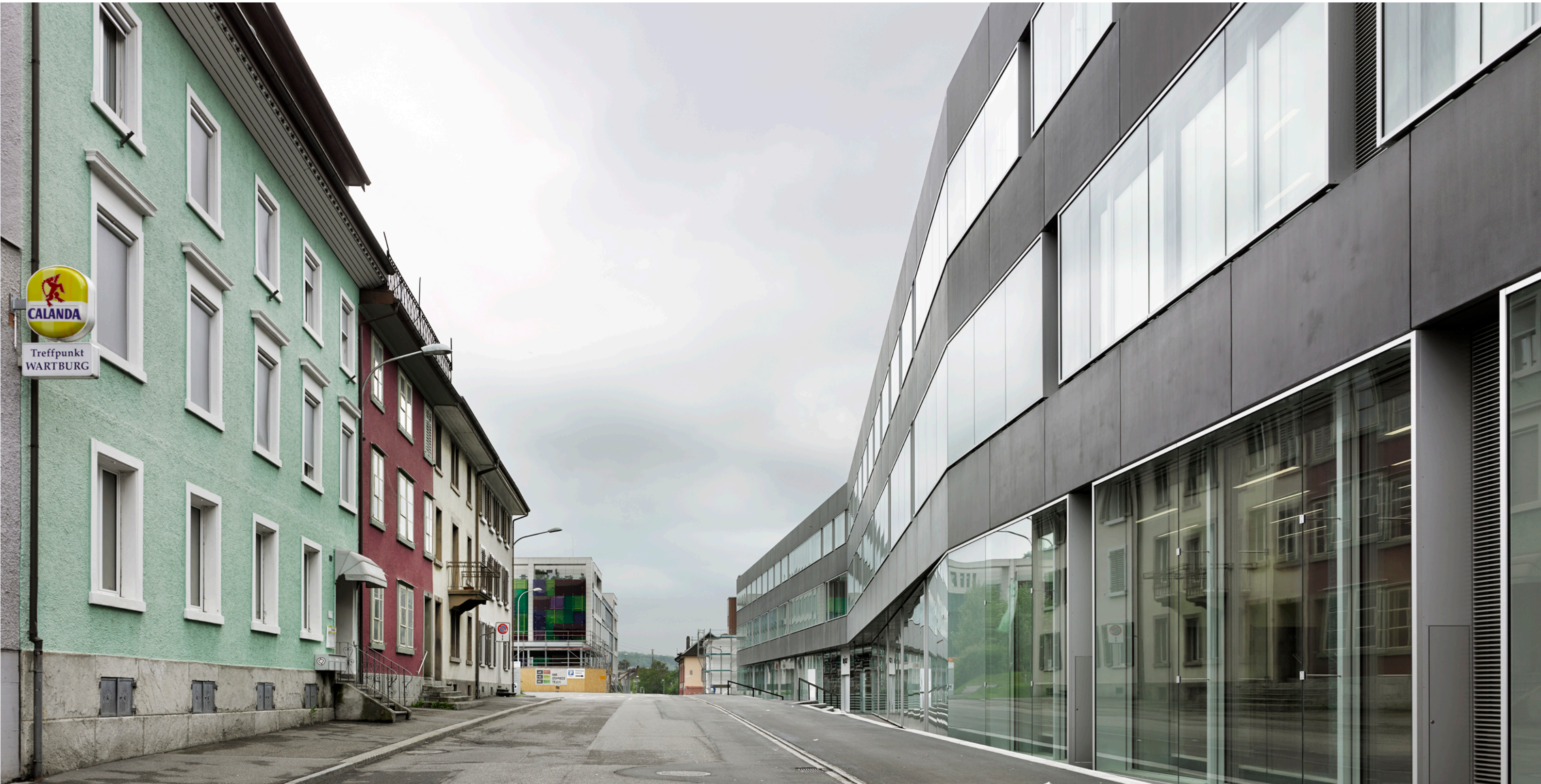
FHNW Olten, Von Roll Strasse, façade est, entrée latérale
