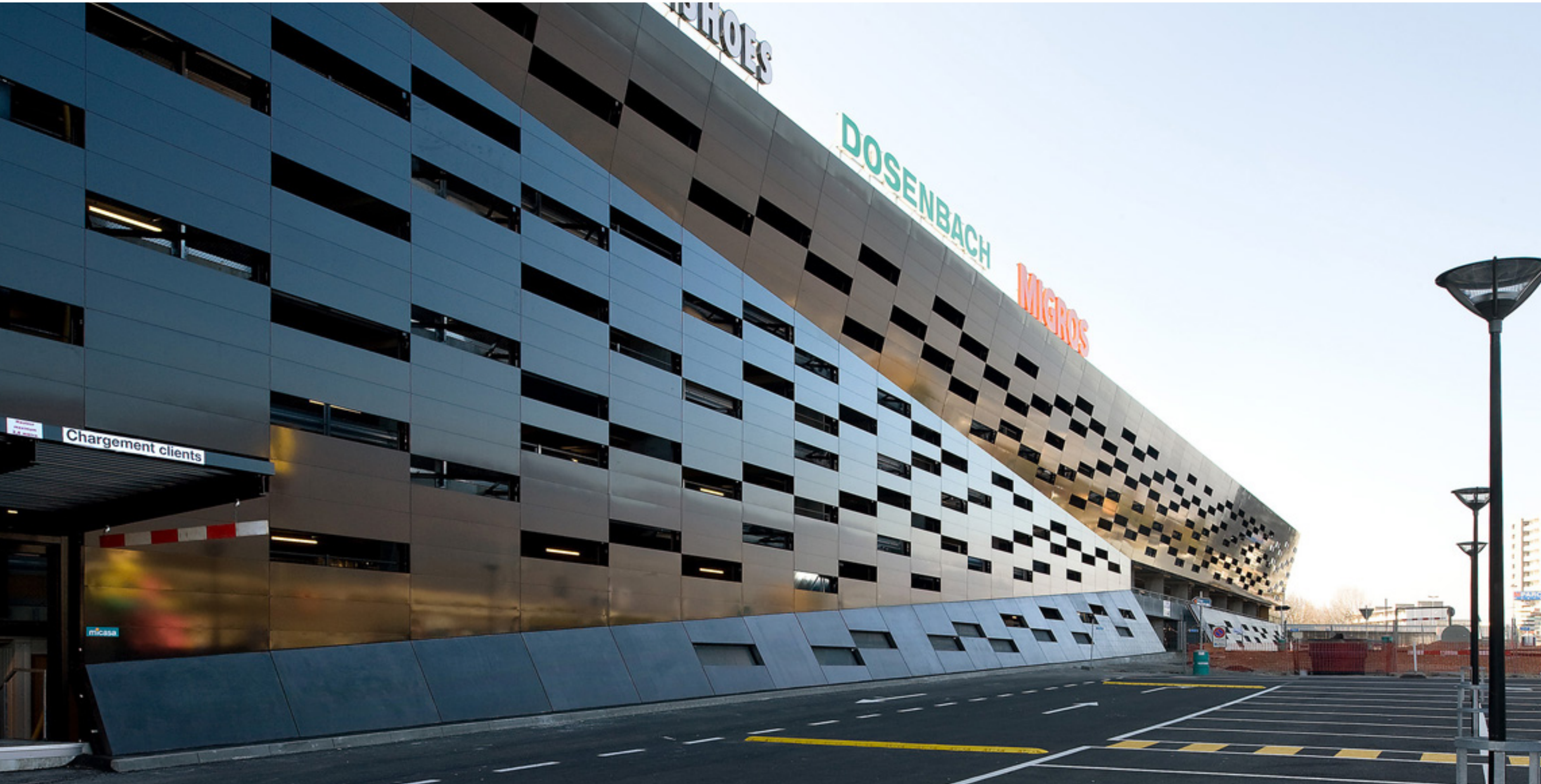
Migros Marin, façade nord
