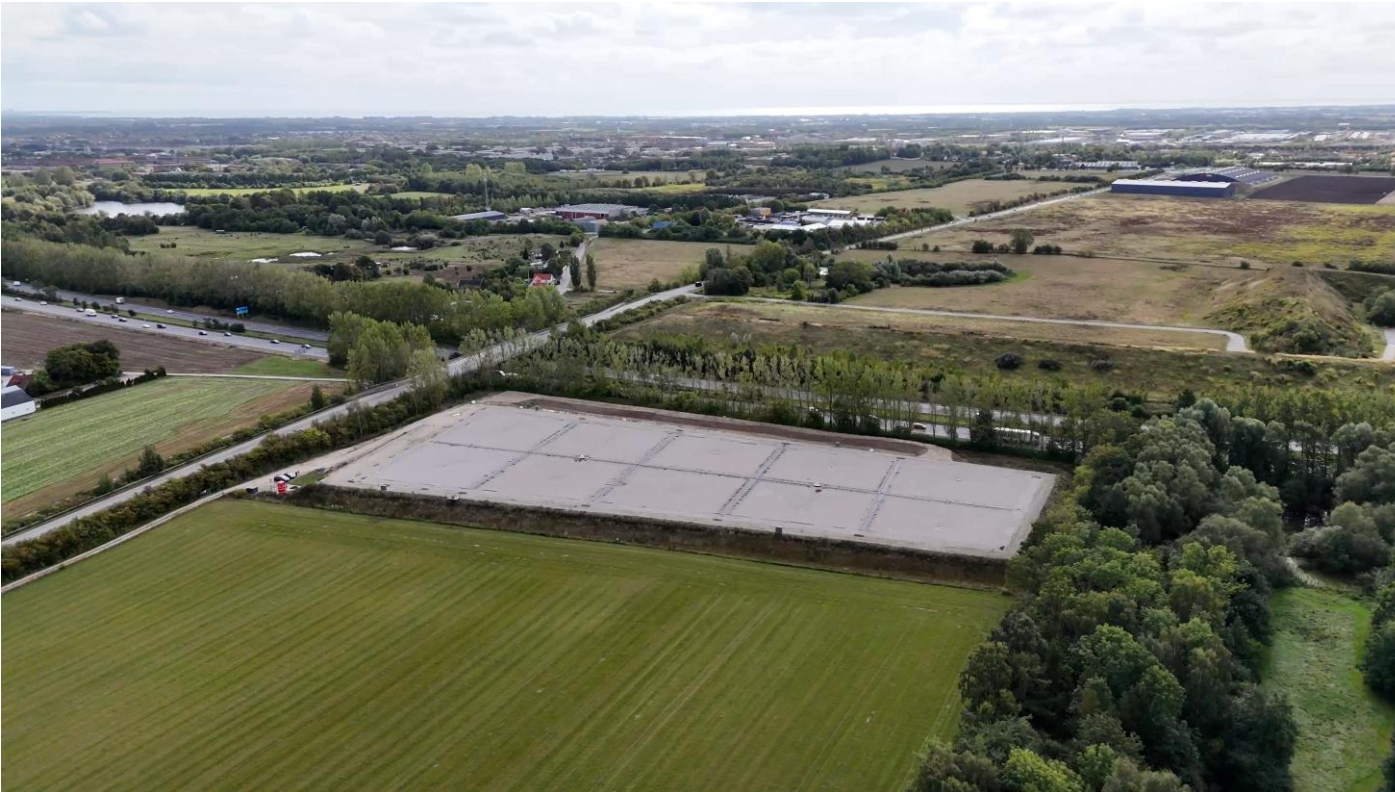
Erdbeckenspeicher: Høje Taastrup / Dänemark, Aalborg CSP
