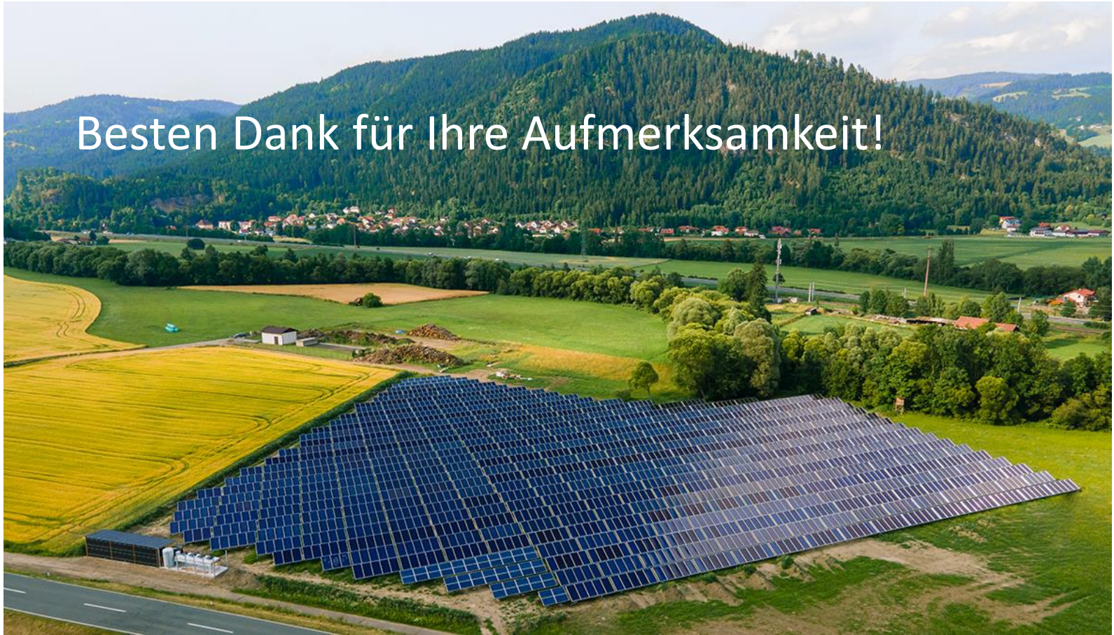
Fernwärme Friesach, Kärnten (AT), 4 MW © Austria Solar
