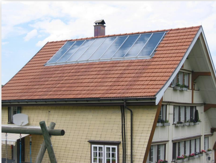
Bisheriger Einsatz in der Schweiz: eher kleinere Anlagen für Warmwasser in Wohnbauten
